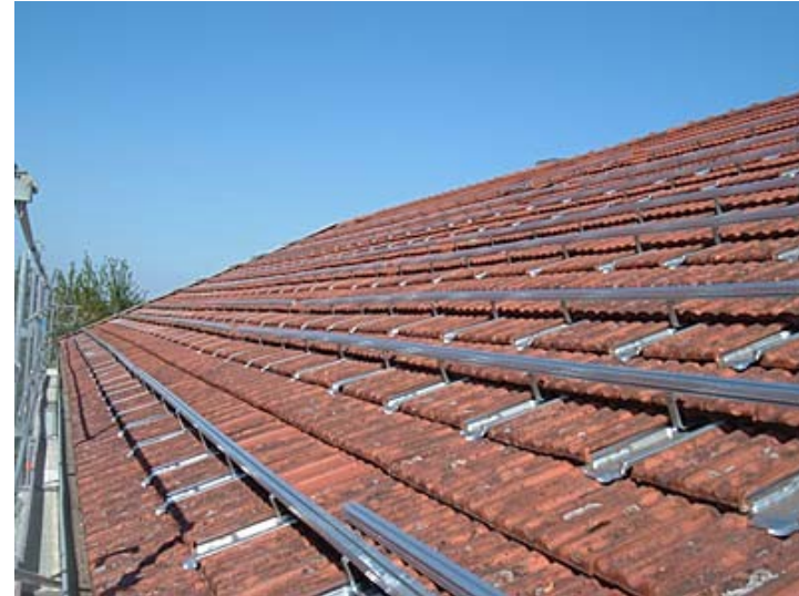
Einhängung über eigene Schindel Bildquelle : pv-lichtwerbung.de
