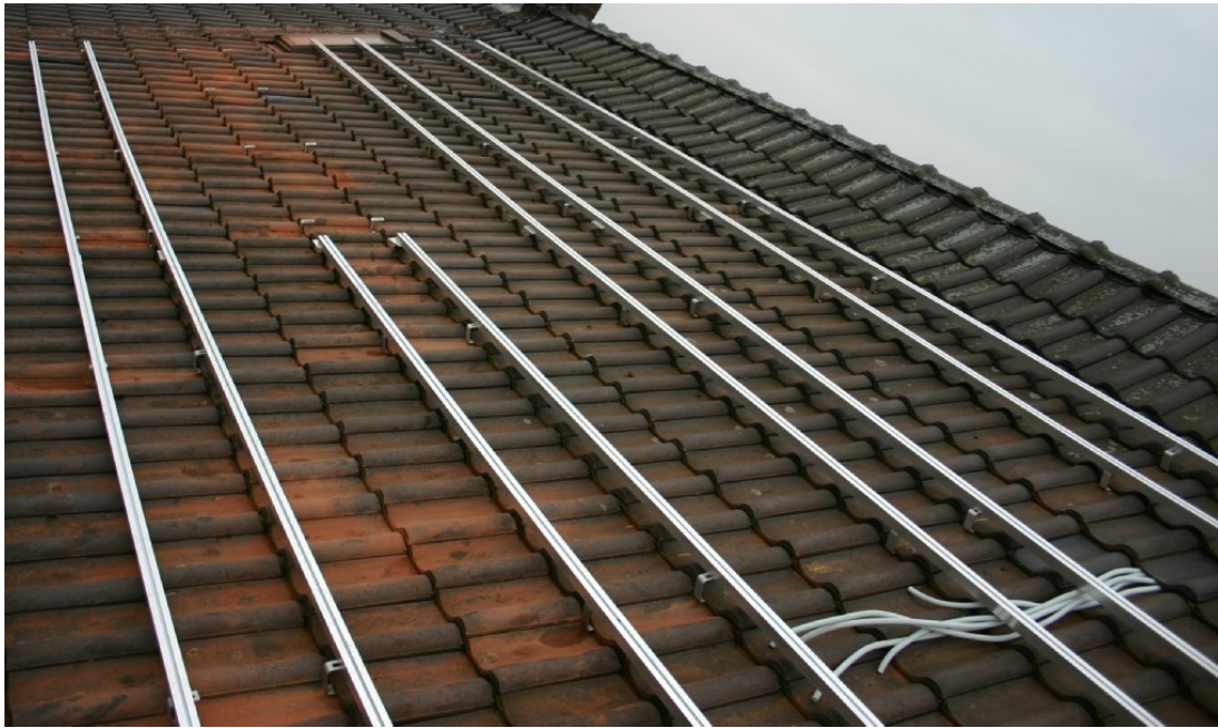
Einhängung unter den Schindeln Bildquelle: solaranlagen-online.de
