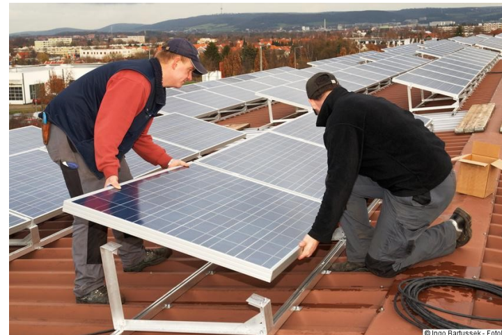
Flachdach Aufständerrung (mit Bohrung) Quelle: solaranlagen.eu
