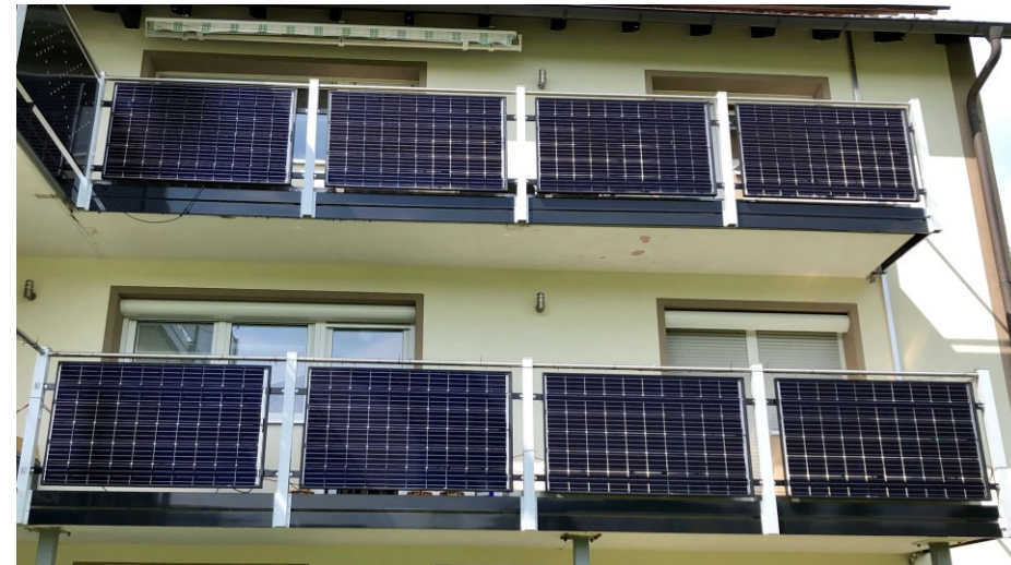
Bildquelle: SOLARWATT GmbH – Balkon-PV ohne Aufständerung
